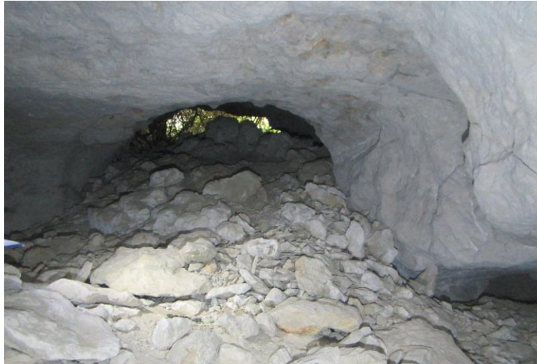
Illustration 10 : Fontis débouchant au jour (D9) associé à une chute de toit (D8) à l'ouest de la carrière
