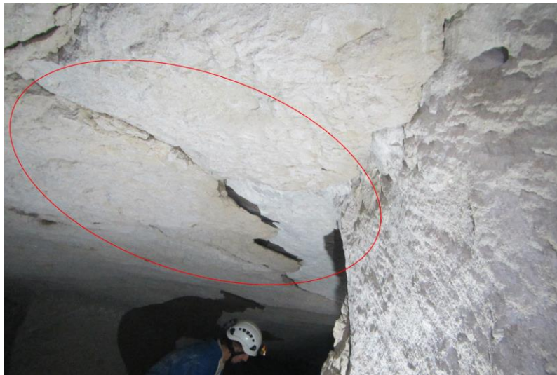
Illustration 11 : Vue sur un décollement de 1 er banc de toit dans la partie sud-est (ici instabilité D11), associée à une fracturation mécanique du toit dense
