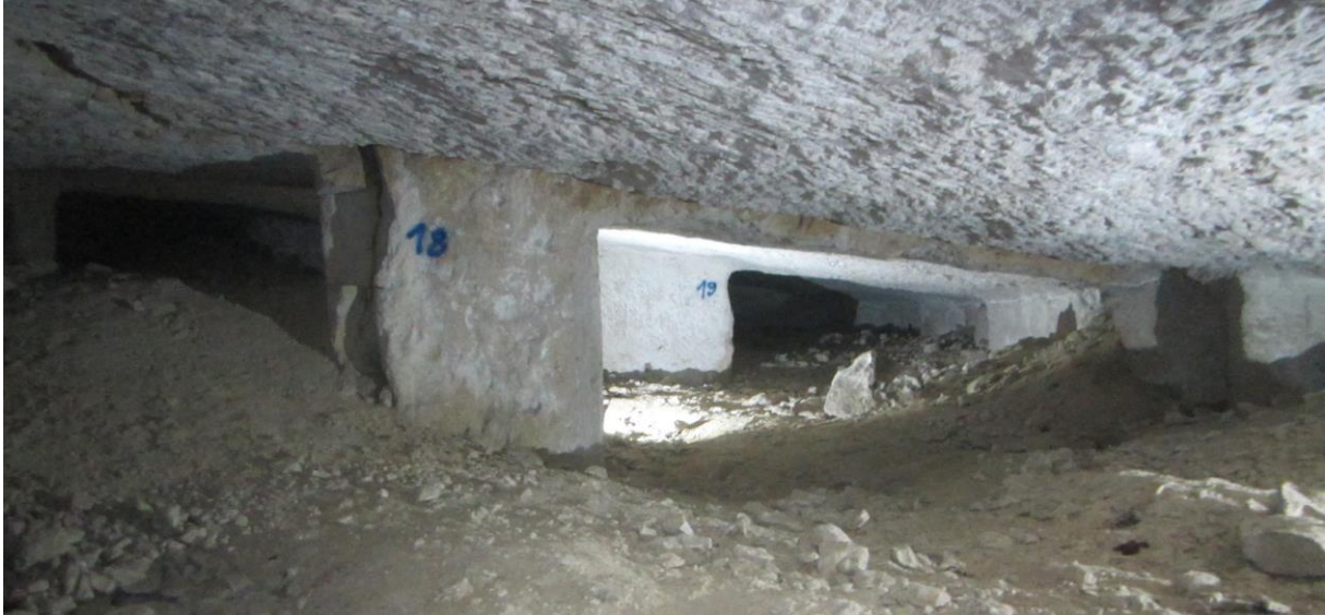
Illustration 3 : Vue sur le pendage du banc exploité vers le nord / nord-est, de l'ordre de 8°
